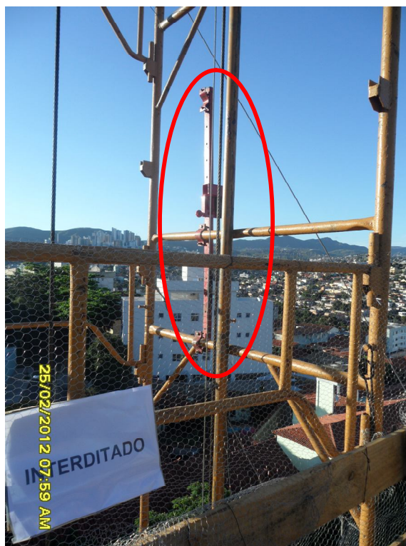
Figura 32 – Limitador de fim de curso superior instalado junto a torre do elevador Fonte: Arquivo pessoal (2012)
