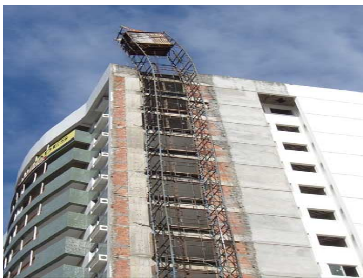
Figura 34 – Acidente Vitória – 07/2009 (elevador ultrapassou o fim do curso e chocou com a viga superior da torre) Fonte: Arquivo pessoal 2009
