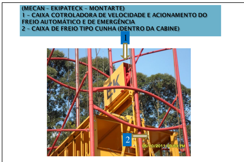
Figura 39 – Caixa controladora de velocidade do freio automático tipo cunha. Fonte: Arquivo Pessoal (2011)
